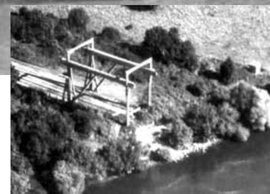
Le portique à demi démonté. Années 1970.
