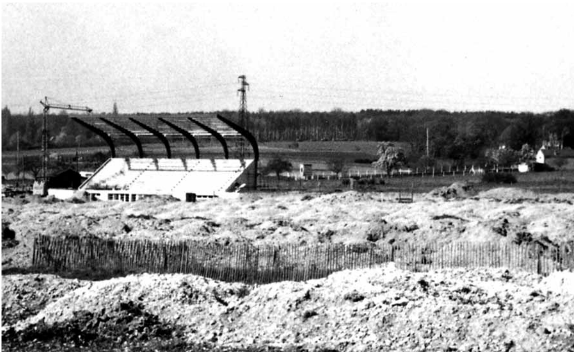
1965-1966, construction de la tribune et des vestiaires du stade municipal qui deviendra stade Marcel-Billard.
