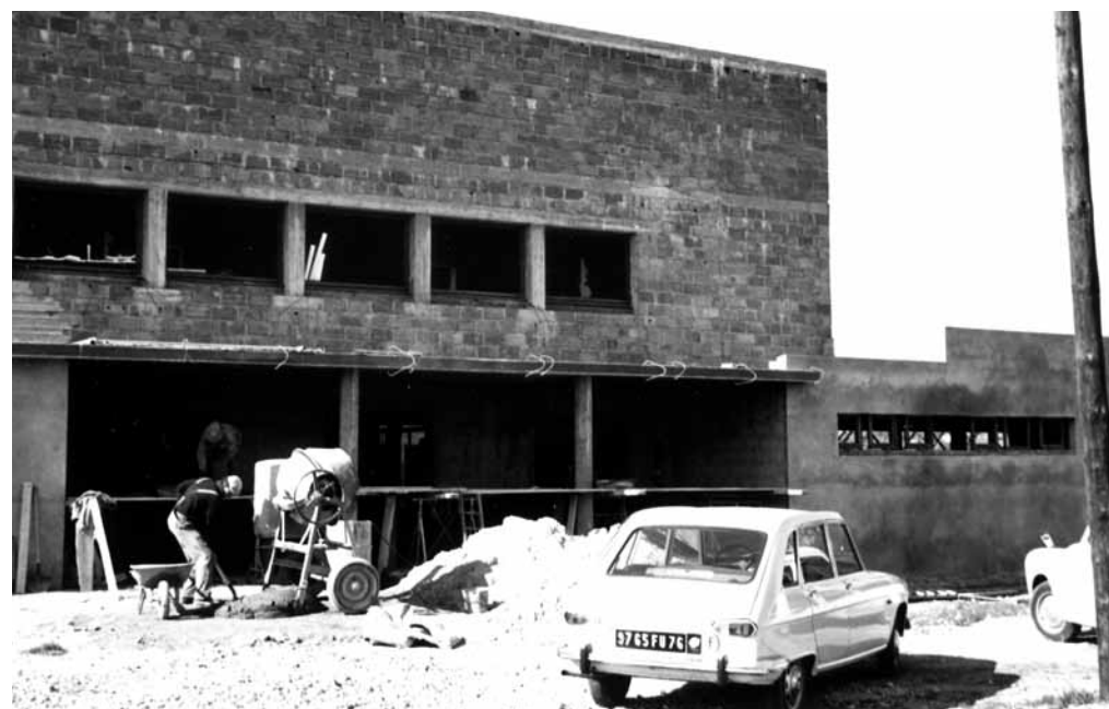
1965-1966, construction du Palais des congrès.
