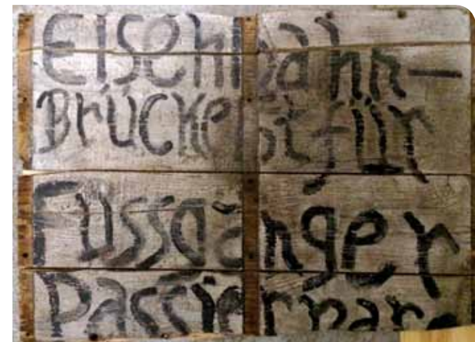
Pancarte placée à l'entrée de la passerelle par l'armée allemande. Texte traduit : "Pont de chemin de fer passage autorisé aux piétons". Photographie prêtée par Fabrice Dholande.
