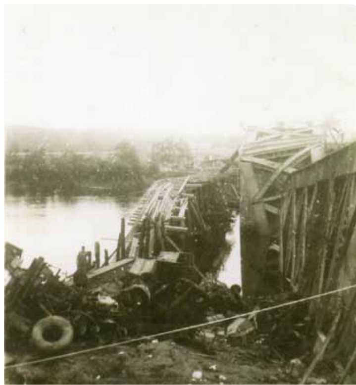
Estacade du pont de Tourville détruite par les bombardements de l'été 1944.
