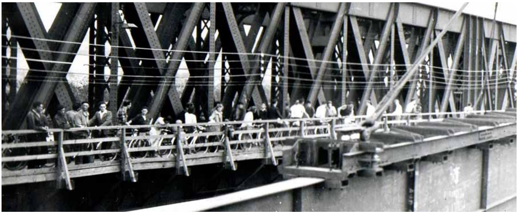
Été-automne 1950, la passerelle du pont de chemin de fer. Au premier plan le futur pont routier en construction. (Photo Achille Plaisant).
